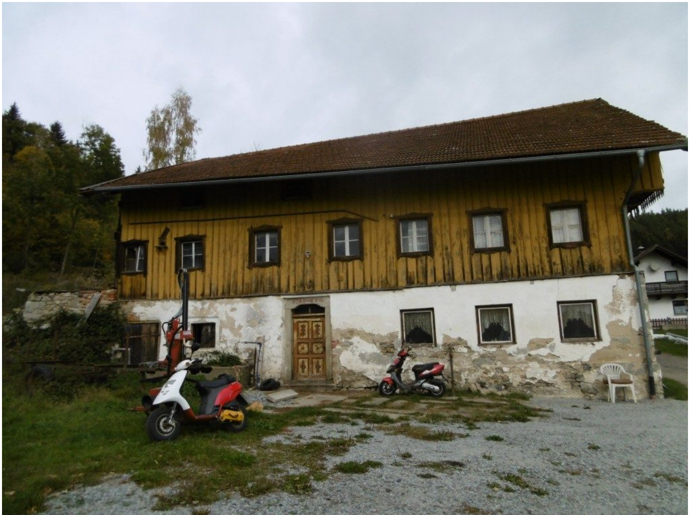
Das Penzkofer-Anwesen liegt am Wolfgangsweg nach Ramersdorf
