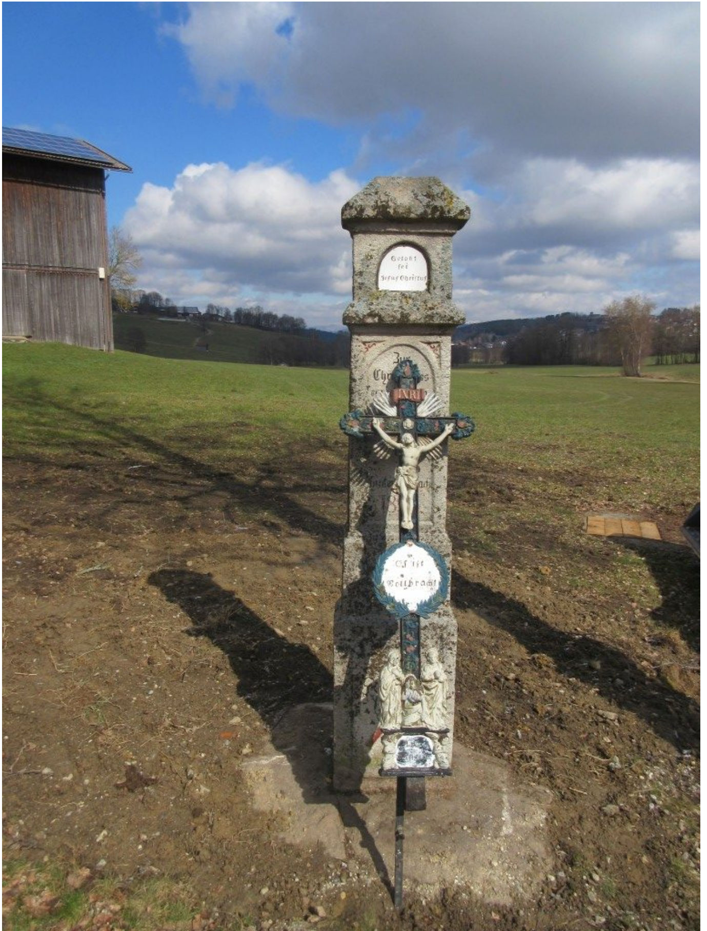
Das Kreuz wurde zur Renovierung jetzt abgenommen.
