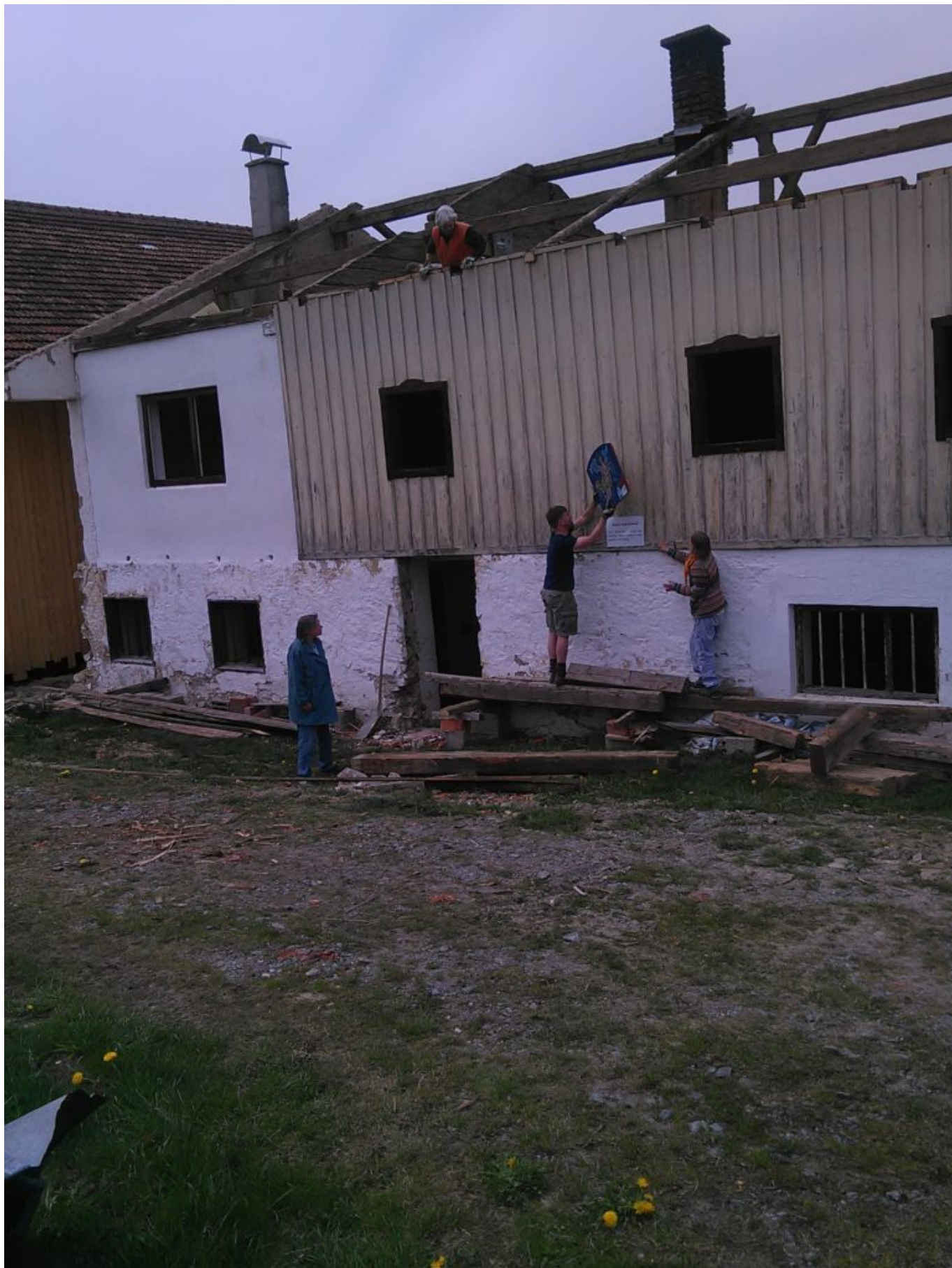
Das Bielmeier-Albert-Wohnhaus wird abgerissen, die Votivtafel mit Engel und Sinnspruch vorsichtig entfernt. Foto: Sylvia
