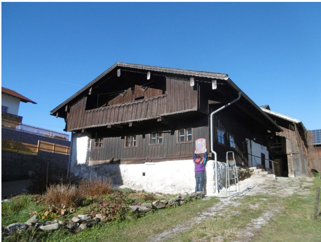
Das denkmalgeschützte Edenhofer-Anwesen in Rechertsried
