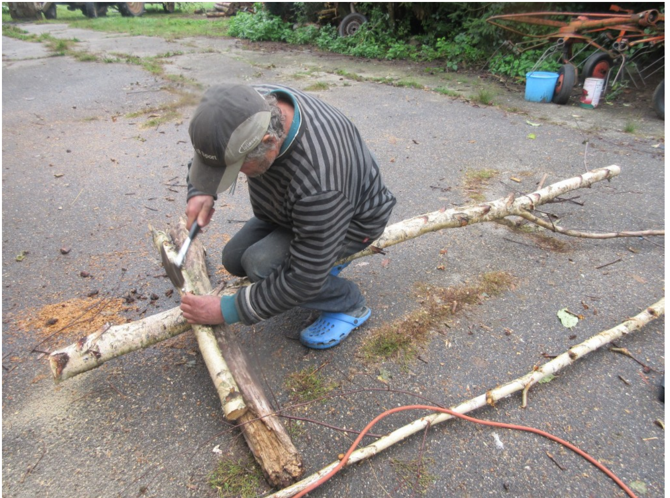
Xaver befestigt den Querbalken.
