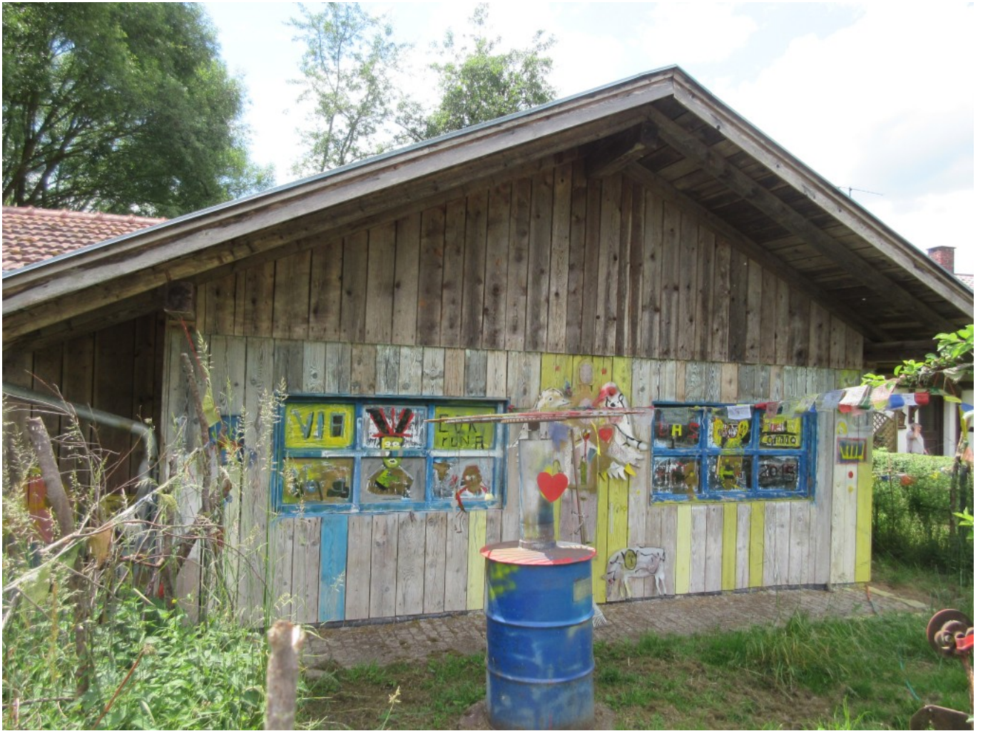
Ölfass als Dekoration und geheimnisvolle Fenster
