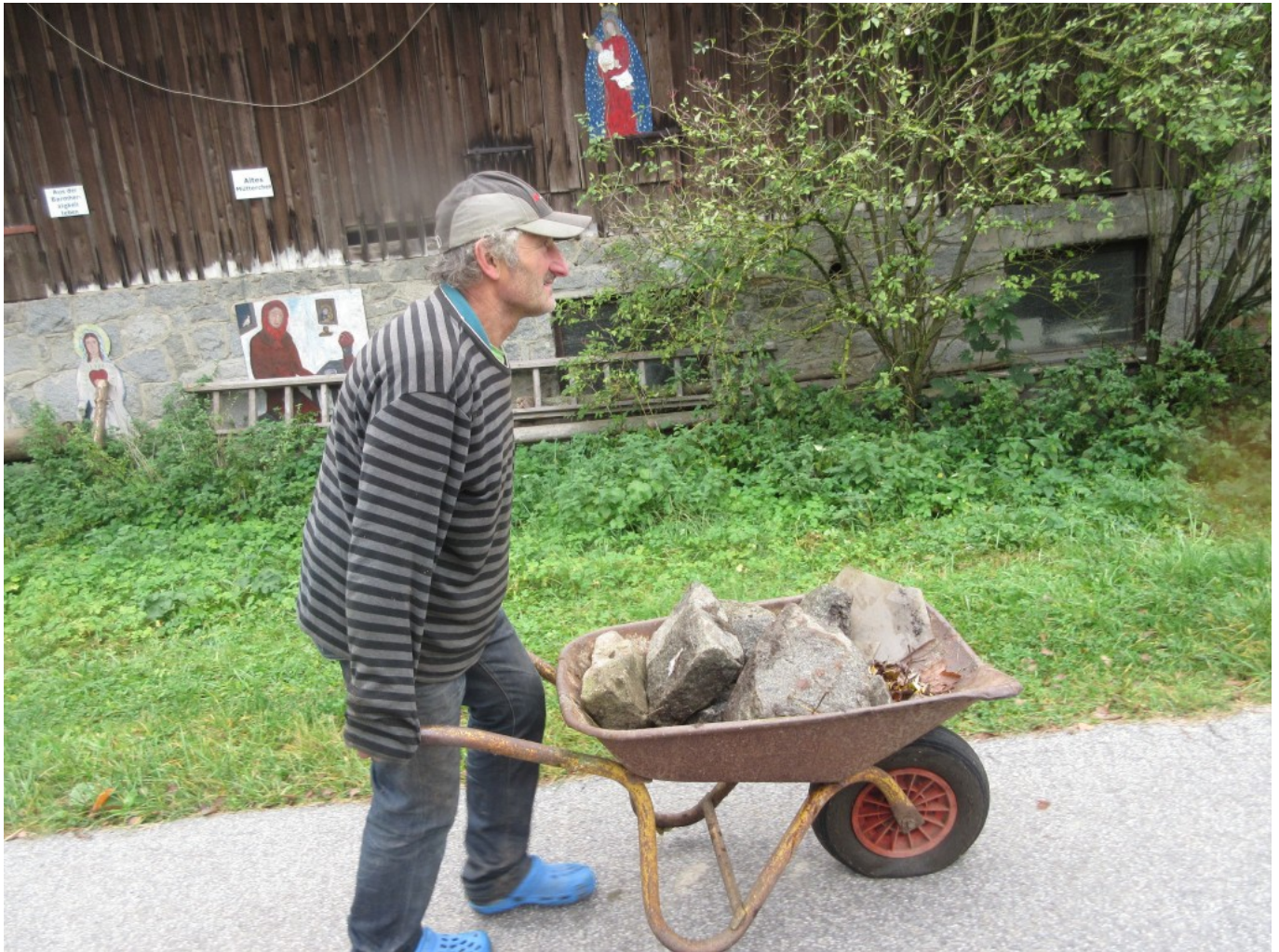
Einige schwere "Weydling-Stoa" = Natursteine werden zusätzliche Stabilität bringen.
