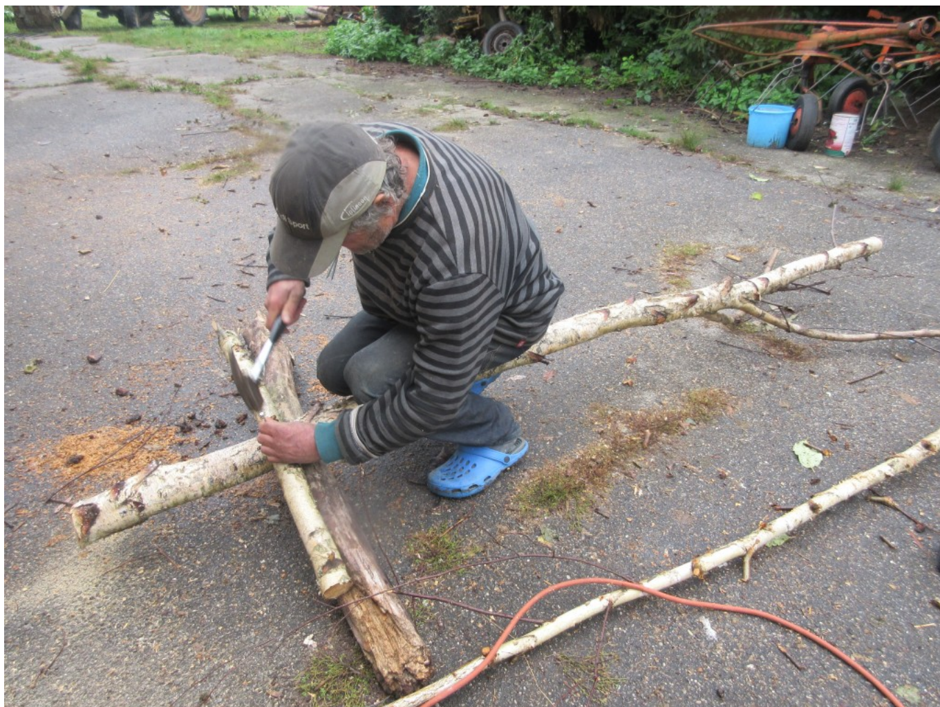
Xaver befestigt den Querbalken.
