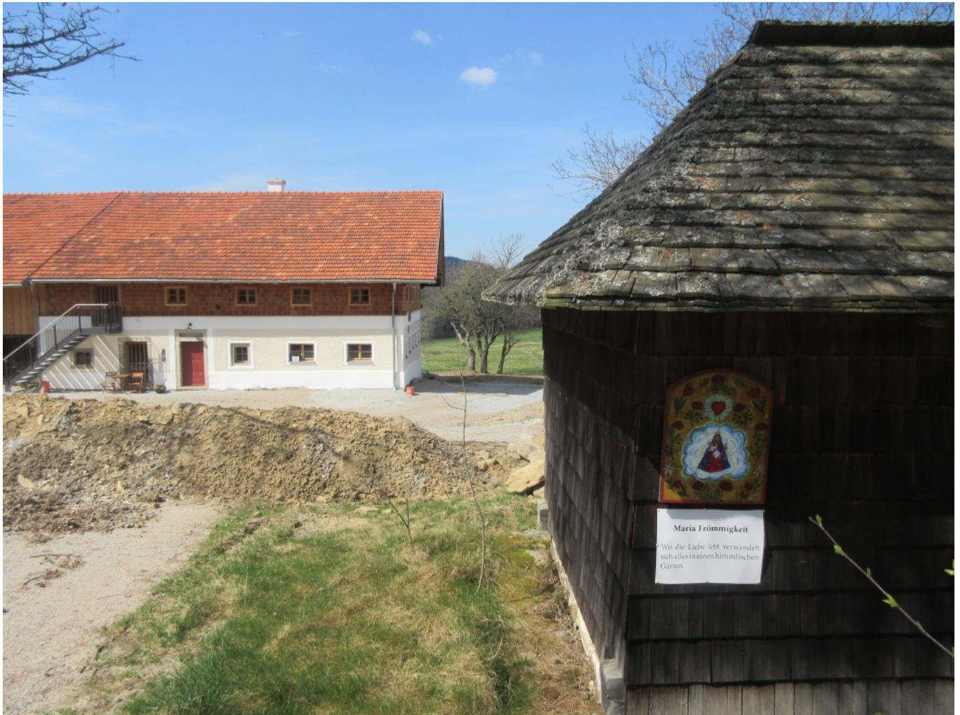
Bei der Gudat-Kapelle: "Maria Frömmigkeit. Wo die Liebe lebt, verwandelt sich alles in einen himmlischen Garten". Das denkmalgeschützte Anwesen neben der uralten Holzkapelle wird derzeit liebevoll renoviert.
