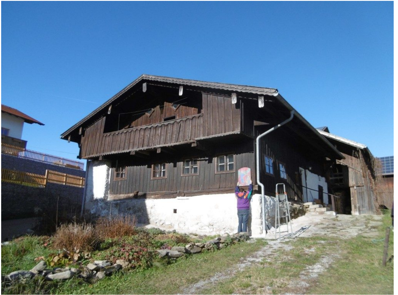
Das denkmalgeschützte Edenhofer-Anwesen in Rechertsried
